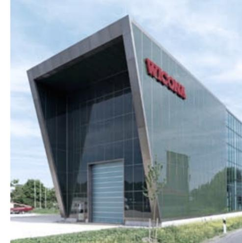
WICONA Test Centre Bellenberg, Prüfzentrum für Fassaden und Fenster. Hier können wir Fassadenmuster von Objektlösungen nach projektspezifischen Vorgaben oder internationalen Normen und Standards testen. Ausgeführt als Plus-Energie-Betriebsgebäude, mit Fassade und Glasdach in Passivhausqualität.
