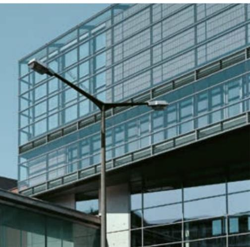
WICTEC DuoWall Doppelfassaden liefern den bestmöglichen Wärmeschutz und nutzen solare Energiegewinne optimal aus. Sie bieten zudem wirksamen Schallschutz – auch bei geöffneten Fenstern. Gebäude-technik-, Sonnenschutz- oder andere Funktionselemente können problemlos integriert werden.
