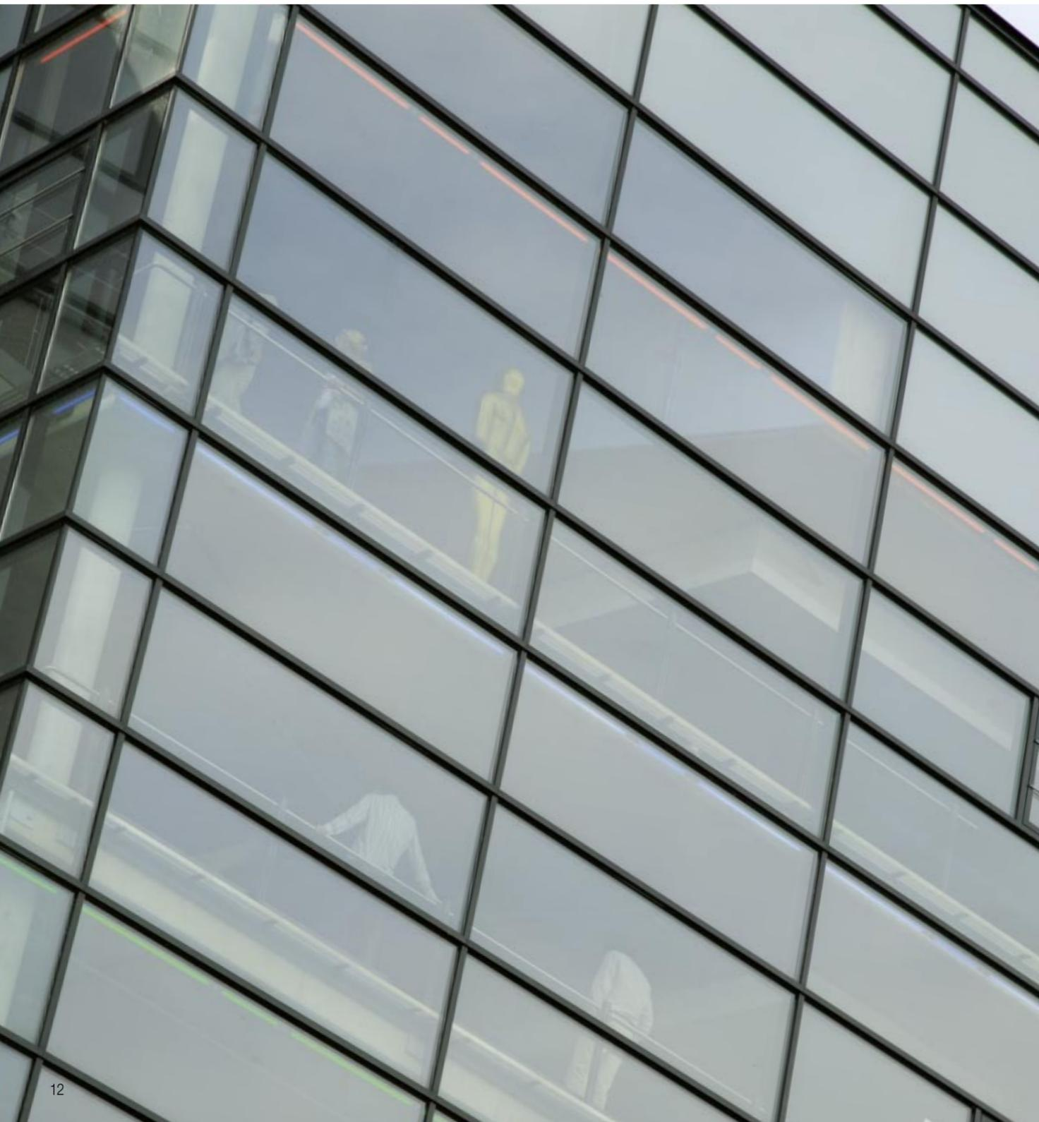
Die Fassadenserie WICTEC 60 ist mit der Ansichtsbreite von 60 mm optimal für ebene Vorhangfassaden und geneigte Glasdachkonstruktionen geeignet.
